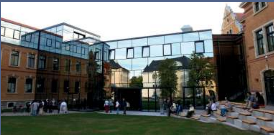
Blick auf den Ergänzungsbau
