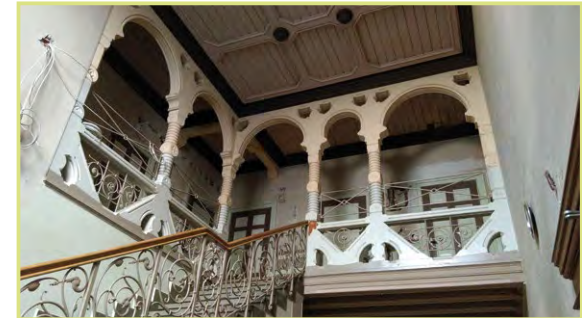
Treppenhaus vor der Sanierung
